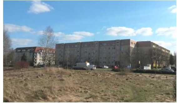
Abb. 7: Geschosswohnungsbau an der R.-Wagner-Straße (Blick aus dem Plangebiet)
